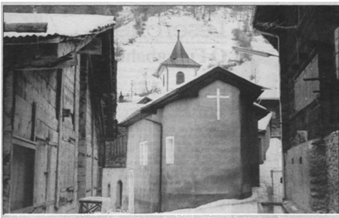
Die Antoniuskapelle steht mitten im Dorf, am direkt angebauten Gemeindehaus und bildet dazu noch den Abschluss einer langgezogenen Häusergruppe. Der Bau selbst besteht aus Felsstein, wurde aber mehrmals mit Verputz renoviert. Kapellenrenovation in Feschel abgeschlossen
