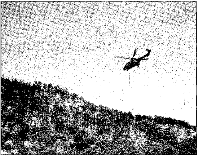
Der Armee-Helikopter im Einsatz: Steine werden weggeflogen, um die Gefahr von Steinschlag auf die Strasse zwischen Susten und Leukerbad zu mindern. ' Foto wb
