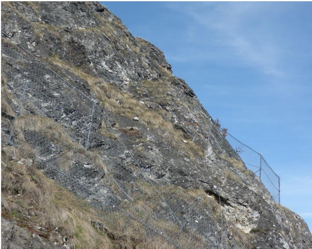
*Abbildung 3: Steinschlagschutzzäune bei GP03*
